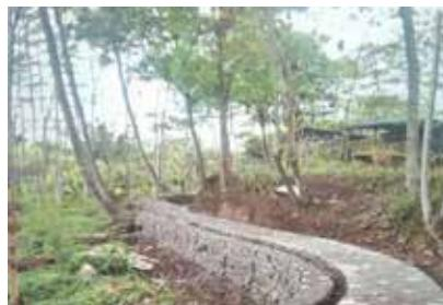
Dana bantuan yang diberikan sebesar Rp50.000.000,- dan digunakan untuk pembangunan talud irigasi. Talud berfungsi untuk menjaga struktur tanah agar tidak bergeser dan menghambat aliran irigasi. Melalui bantuan infrastruktur berupa pembangunan talud irigasi diharapkan dapat memperbaiki sistem aliran air dan mengoptimalkan pengairan bagi lahan pertanian di sekitar Kelurahan Ngempon.
