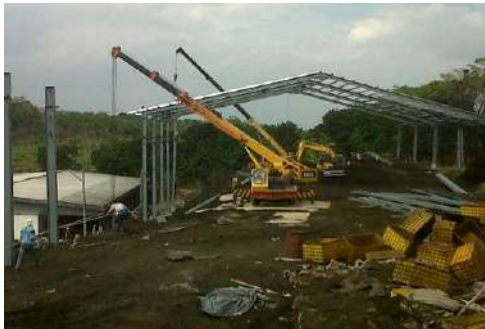
Gambar : Pemasangan Rangka Atap
