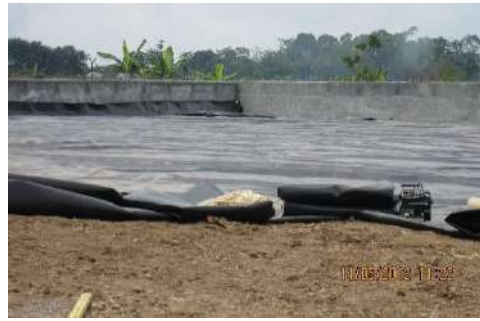
Gambar : Pemasangan Geotex
