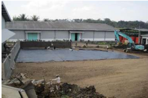
Gambar : Pemasangan Geotex
