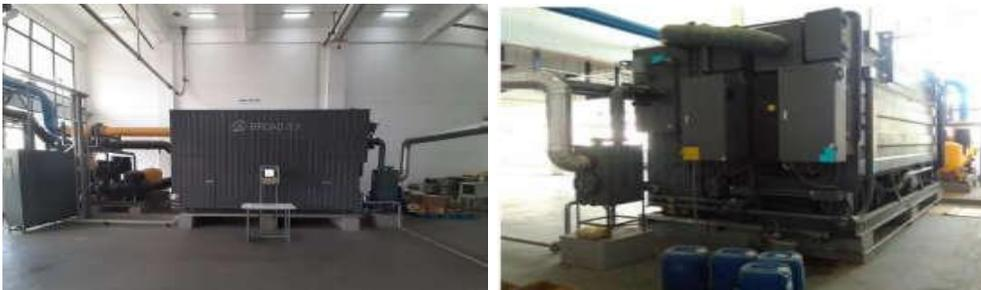
**Gambar 4.1. *Absorption Chiller* di Unit COD-2**
